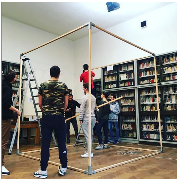
Lavori di montaggio in biblioteca.
