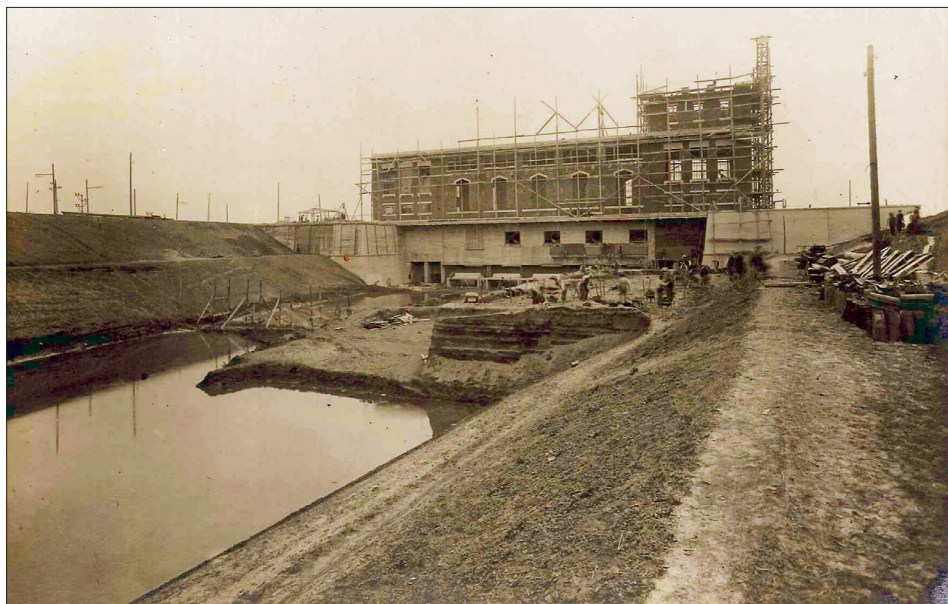
Fig. 7. Il Nodo idrovoro di Mondine durante la costruzione: la fotografia, datata 1923, ritrae lo scavo del bacino di scarico, [archivio del Consorzio di bonifica dell'Emilia centrale].
