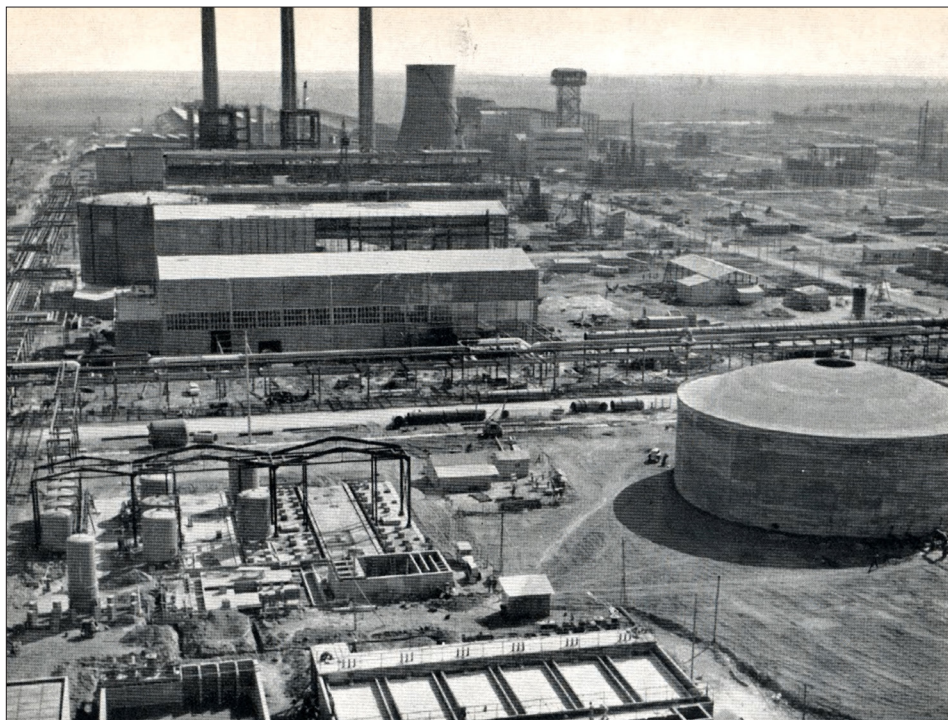
Fig. 2. Anic di Ravenna, veduta parziale dello stabilimento in fase avanzata di costruzione. Sono visibili l'impianto di trattamento e depurazione dell'acqua, l'impianto di frazionamento dell'aria, la centrale termoelettrica e di produzione del vapore; sullo sfondo a destra l'impianto per il nitrato d'ammonio. Fine anni Cinquanta. [Anic, Benvenuti all'ANIC, s.d. ma 1959].
