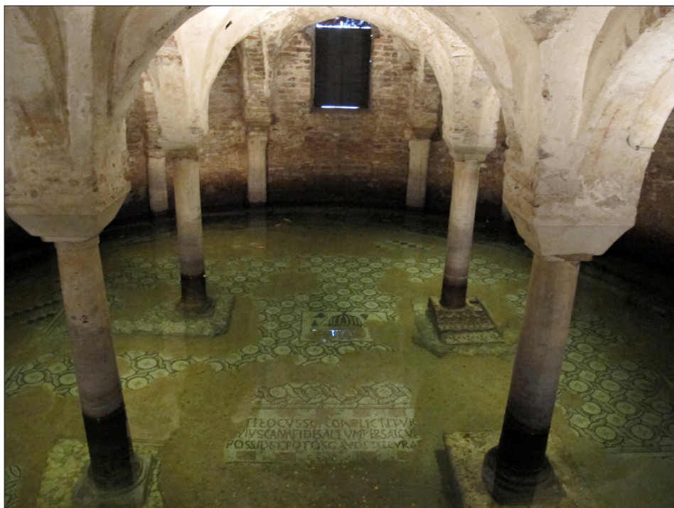
Fig. 4. La subsidenza a Ravenna ha causato l'inondazione della cripta della Basilica di San Francesco, un fenomeno che si verifica a causa dell'abbassamento del terreno sottostante. Questo rende il pavimento della cripta, che risale al IX-X secolo, costantemente coperto [ https://commons.wikimedia.org/wiki/File:Ravenna,_s._francesco,_int.,_cripta_del_IX-X_sec._02.JPG ].
