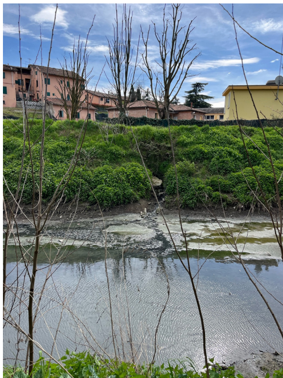
Fig. 8. Frequenti immissioni di acque scure e maleodoranti, probabili reflui urbani, aggravano la condizione ambientale del canale.
