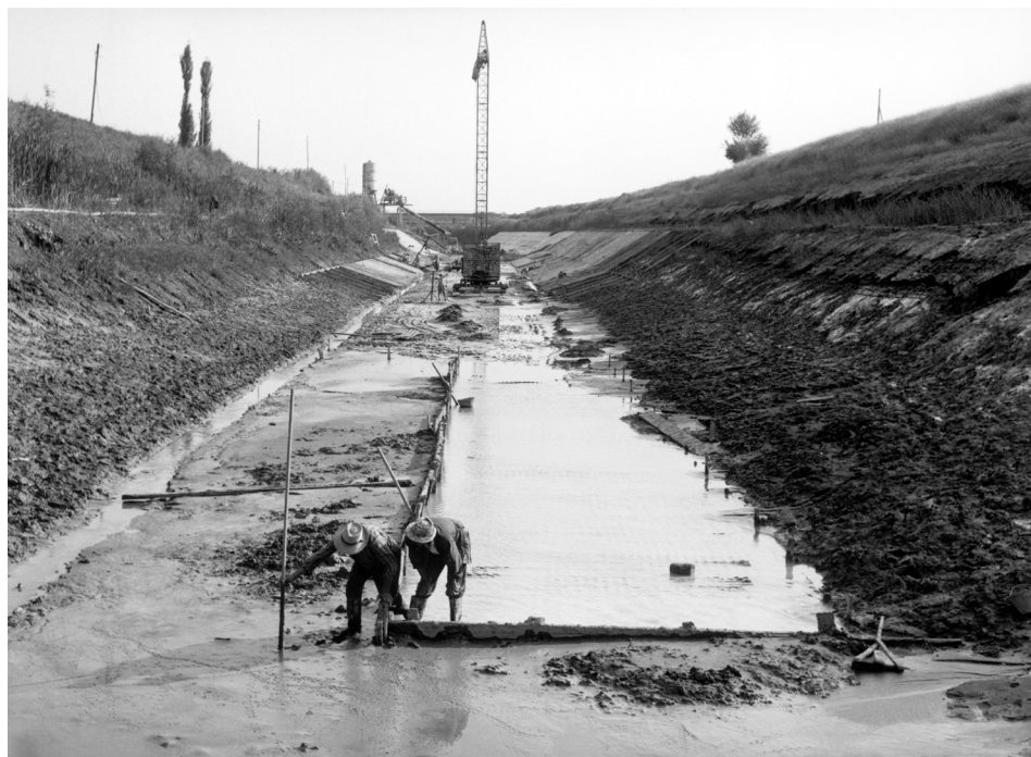
Fig. 1. Il CER in costruzione nella pianura bolognese negli anni Sessanta [Archivio Consorzio CER - Fondo Pasquali].
