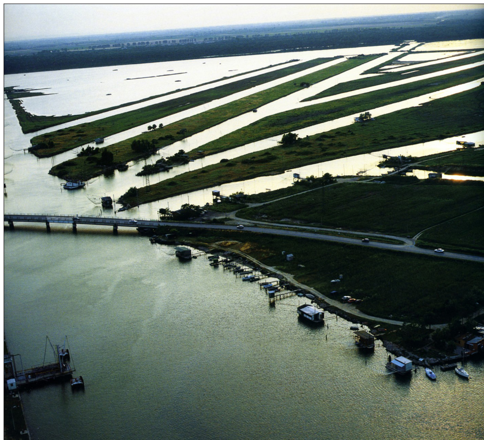
Fig. 5. La Valle Baiona alla confluenza con il Porto canale di Ravenna.
