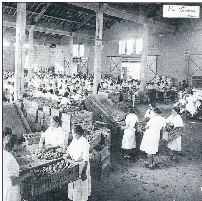
Interno del reparto selezione della ditta di esportazione frutta "Cortesi & Savorelli" di Bagnacavallo, 1937 [Bagnacavallo 1900-1950. Immagini e documenti del primo cinquantennio del '900 1999, 62].
